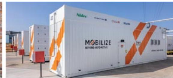
◀▲ Las baterías tienen una segunda vida útil, sustituyendo a grupos electrógenos de combustibles fósiles, o almacenando hasta 70 MWh y restituyendo energía a la red posteriormente.
