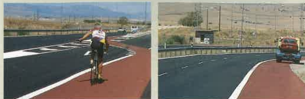
El carril de deceleración se ve interrumpido por el nuevo carril-bici, desvirtuando su uso. La adecuación del carril al uso por bicicletas no invalida su utilización reglamentaria.
