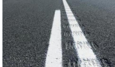
▲ Las bandas sonoras bordean la marca vial de separación de sentidos, con un ancho de huella de 20 centímetros y una profundidad de 1,2 centímetros.
