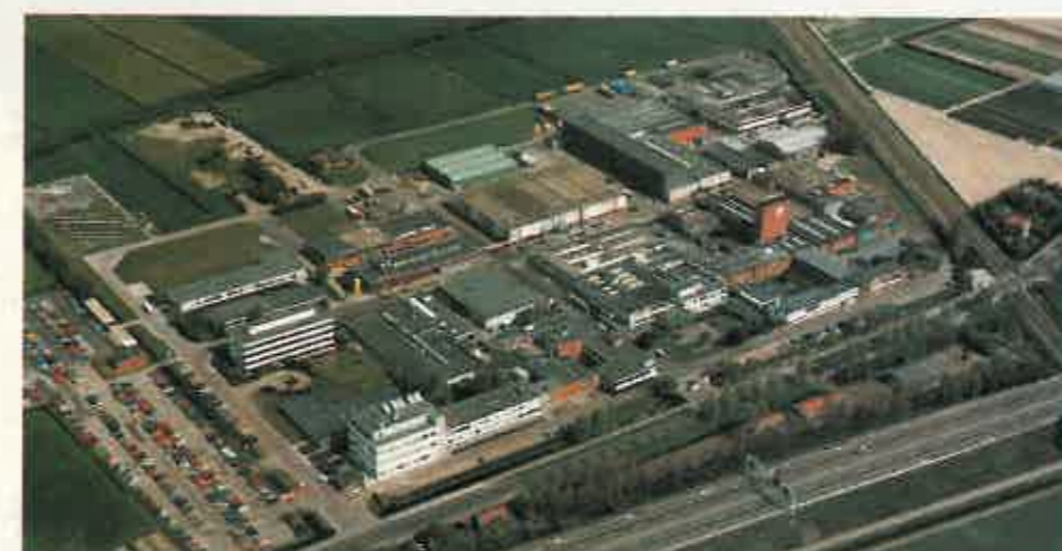
Vista aérea de la fábrica de Sikkens en Sassenheim (Holanda). Unas instalaciones completas para fabricar pintura de alta tecnología.
