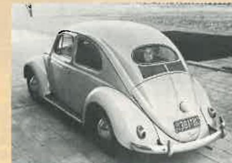
■ Volkswagen. 1.192 centímetros cúbicos, 30 caballos, cuatro cilindros horizontales opuestos, refrigeración por aire, 85.960 pesetas.
