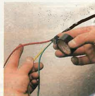
**7** En el tramo en el que los cables discurran juntos proceda al encintado de los mismos. Cogiendo los cables desde un extremo haga una funda con cinta aislante. De esta manera los cables quedan protegidos.
